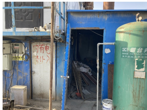
危险废物暂存间
